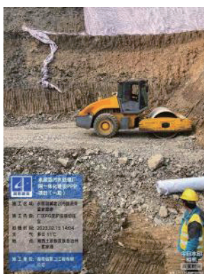
> 图2 碾压压实施工
