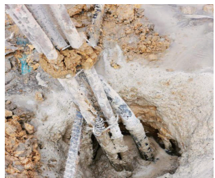
> 图4 孔口设置吊筋及补浆
