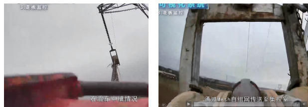
> 图5 护线管过滑车过程安全监控
