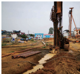
> 图3 普通抗浮锚杆双管成孔
