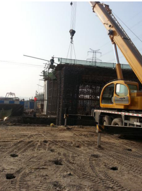
> 图1 钢筋骨架整体吊装
