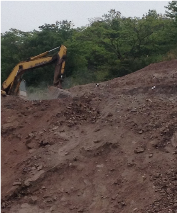
> 图4 工程应用中多目标靶板安装图
