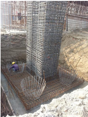
> 图2 连接承台底层水平主筋
