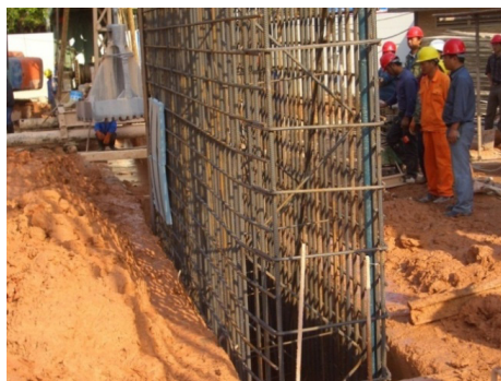
> 图2 钢筋网片入槽
