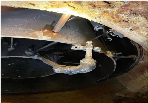
> 图 5 改造两年后壁温元件照片
