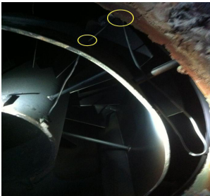
> 图 2 改造后的壁温测温热电偶安装路径
