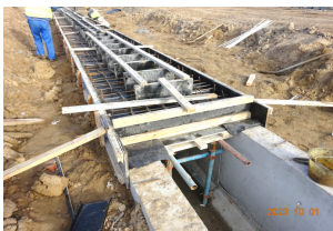
钢筋、泄水孔模板安装完成
