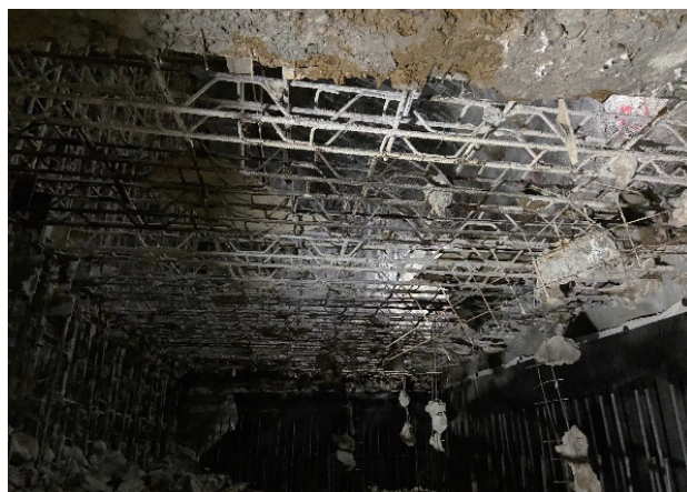
>图11 中隔壁拆除现场图
