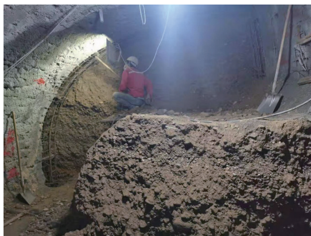
>图7 1号洞室格栅拱架安装现场图
