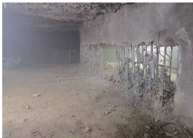
>图12 临时仰拱拆除现场图
