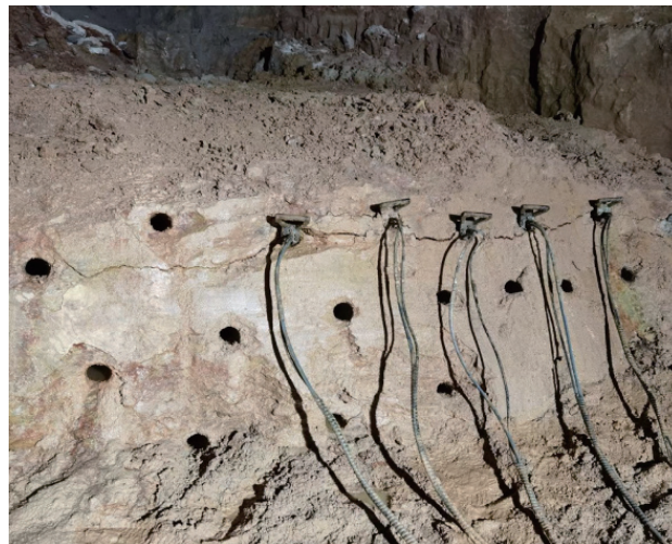
>图6 现场劈裂作业图
