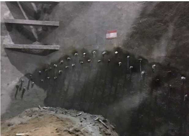
>图2 马头门加固示意图
